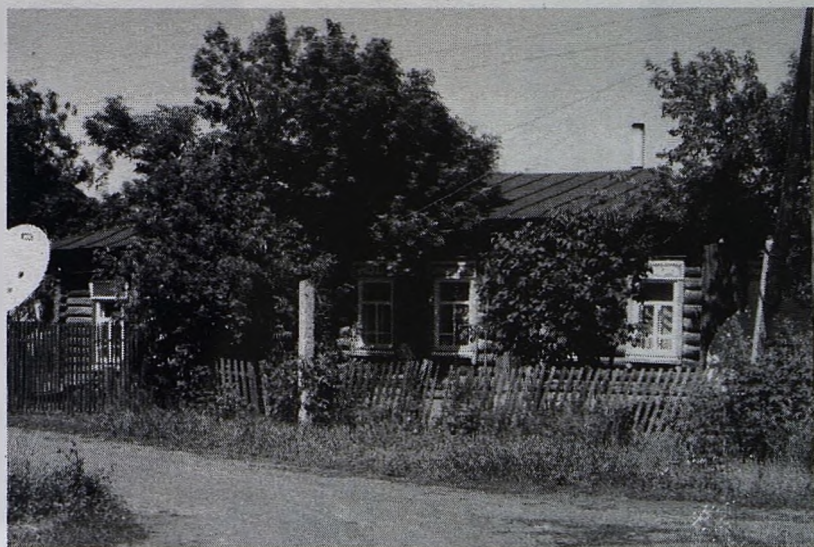
Современное состояние дома А.П.Шехтера
