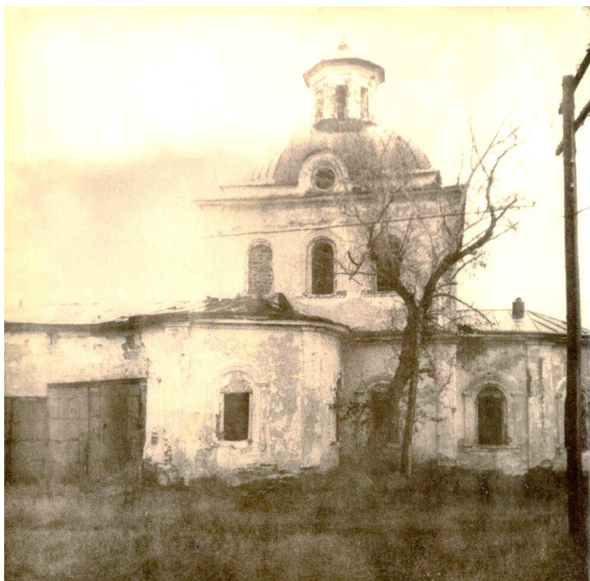
Южная сторона храма с воротами для пожарных машин
