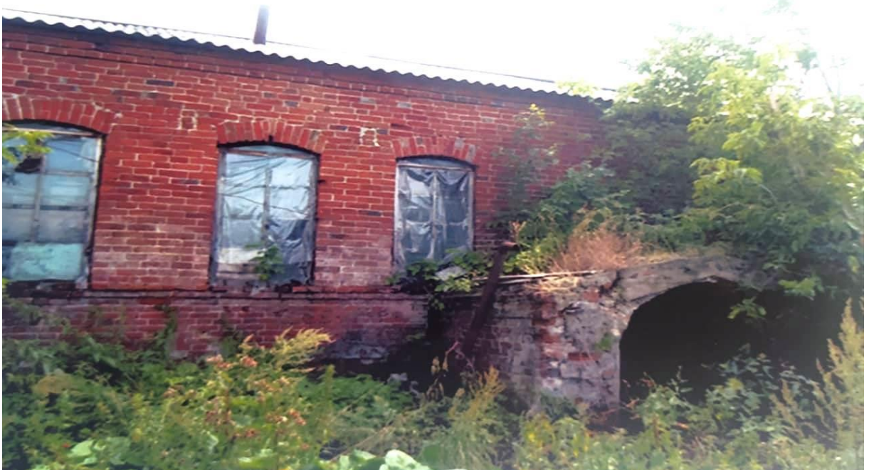
Северная сторона дома Кладенова со входом в подвал. Фото 1999 года.
