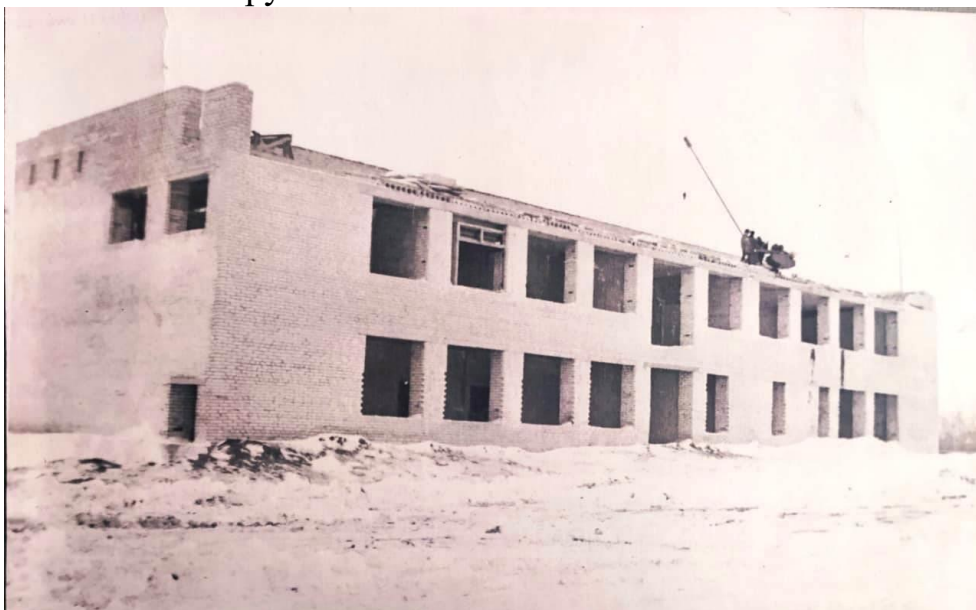
Строительство совхозного Дома культуры. Начало 70-х годов
