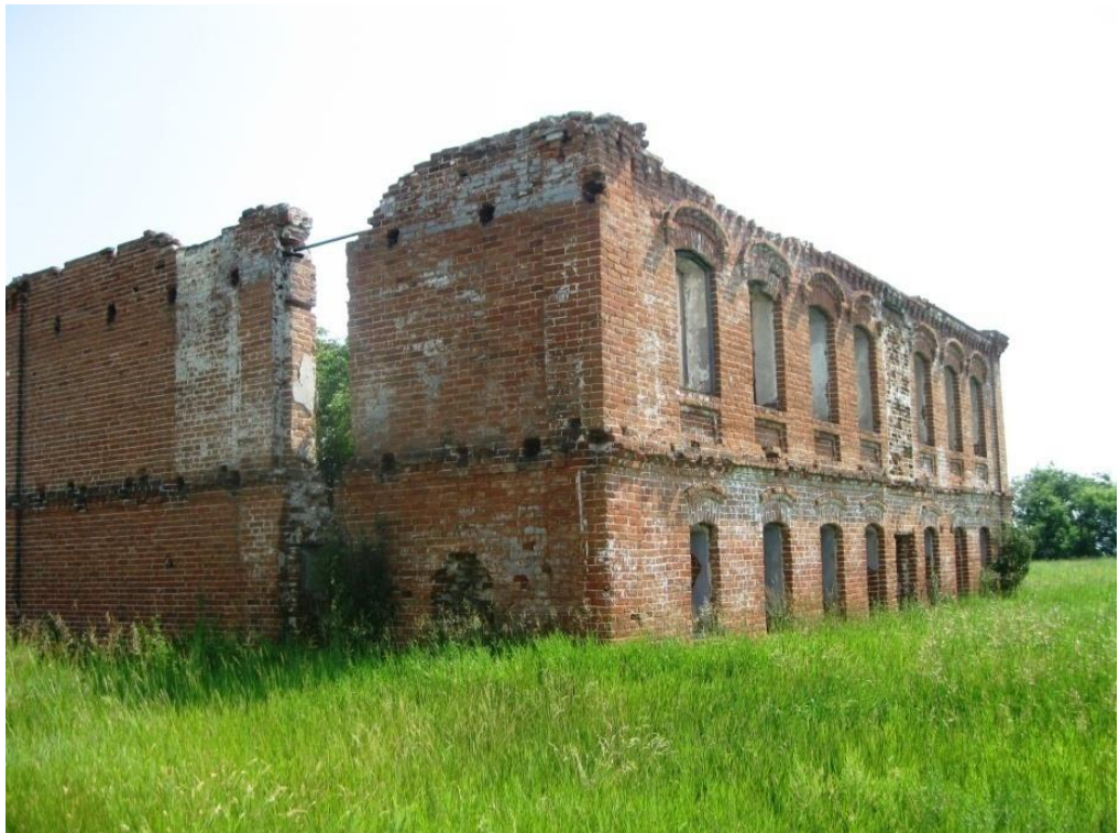
Северо-западная часть стены школы
