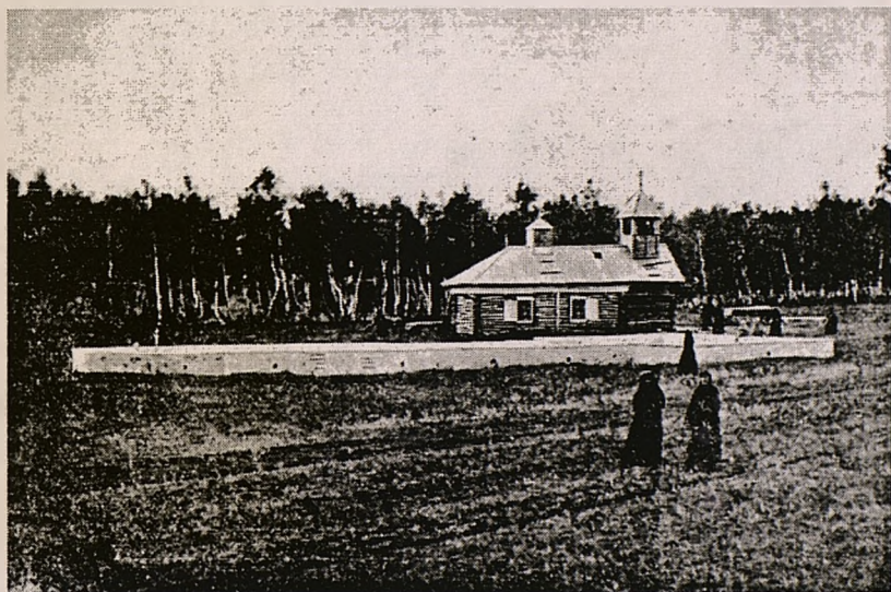
Закладка фундамента Троицкой церкви монастыря, 1899 год
